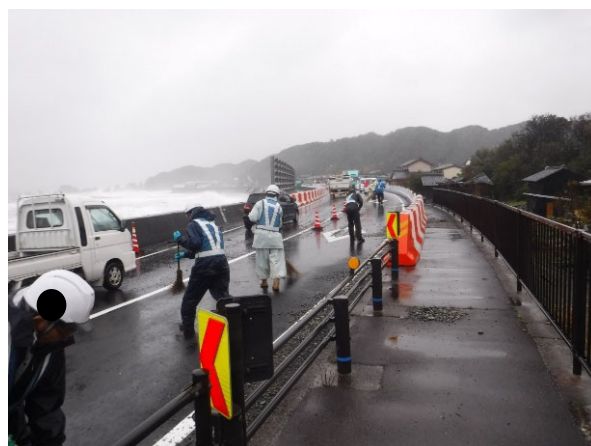
越波後の路面清掃
