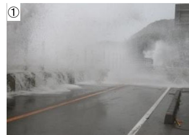
▲並行する国道42号 【台風による越波状況】
