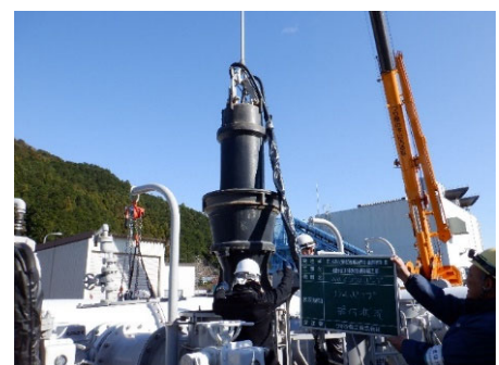
相野谷川排水機場ポンプ修繕
