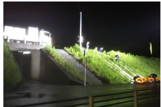
排水ポンプ車配備状況(紀宝町)
