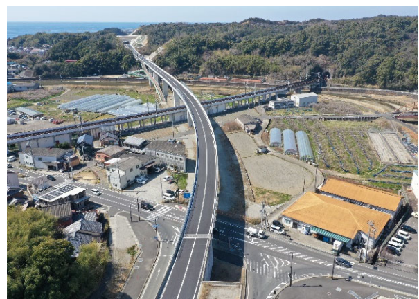
②芳養ランプ交差点付近 (芳養高架橋)
