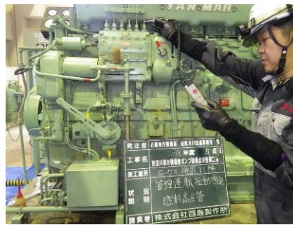
排水機場の点検
