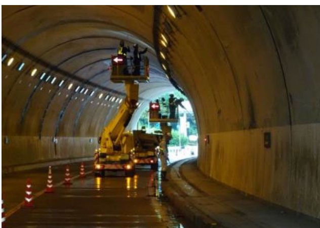
近接目視点検
