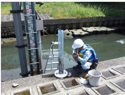
水位センサーの点検
