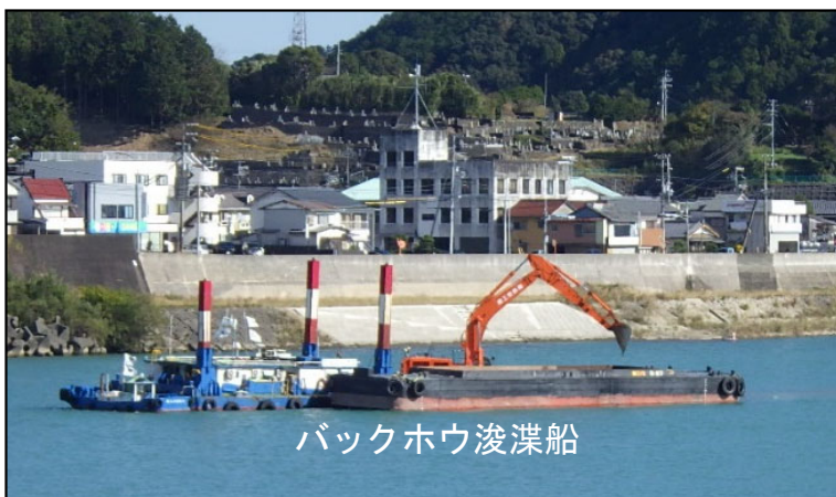
▲熊野川河道掘削
