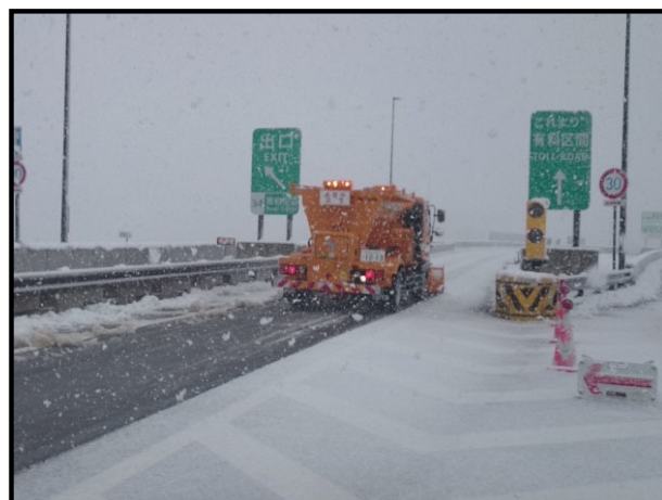
凍結防止剤散布作業
