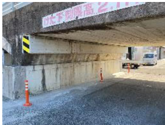
耐震補強工事（変位制限装置・縁端拡幅）
