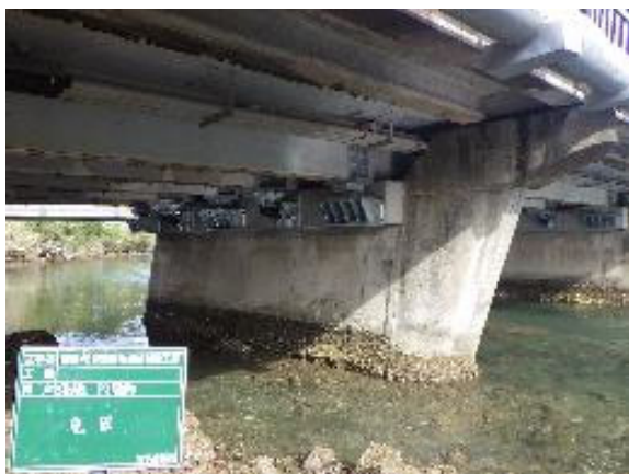
耐震補強工事（落橋防止システム）
