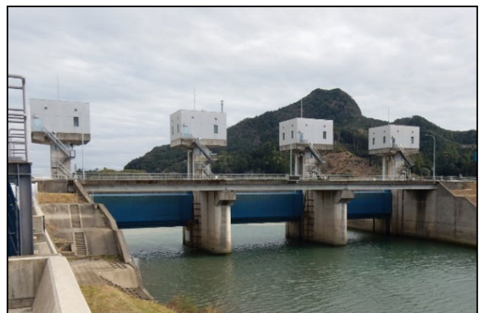
▲鮎田水門耐震補強
