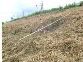
堤防のり面の陥没状況
