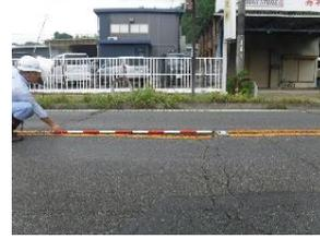
堤防天端の沈下状況
