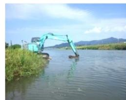
河床水中部の試料採取状況
