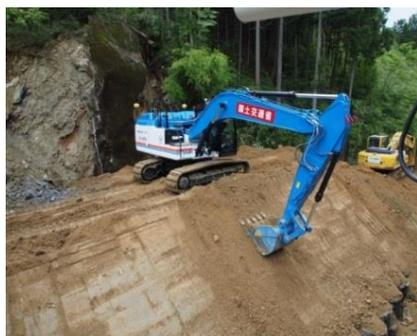
分解対応型BH(無人化施工状況)
