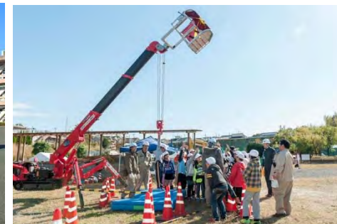
カニクレーン
