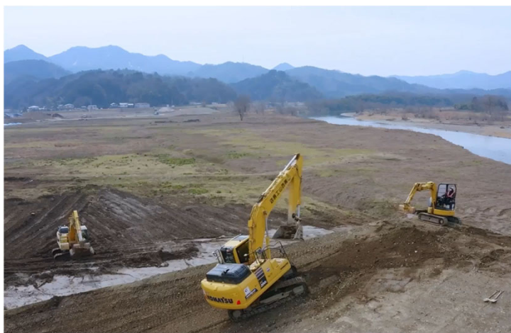
ICT施工Stage II 活用工事（イメージ）
