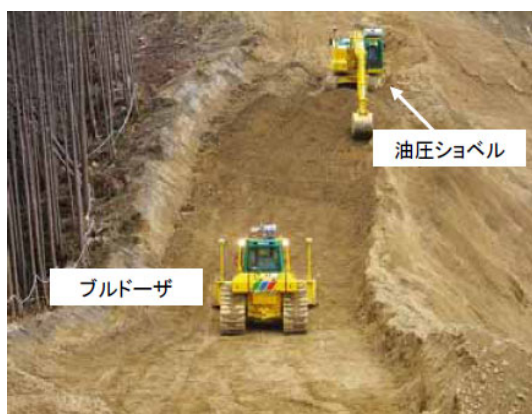
遠隔施工による法面整形・掘削
