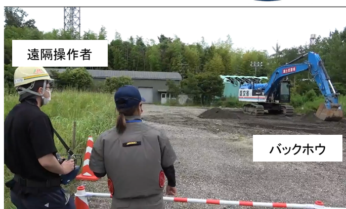
バックホウの遠隔施工
