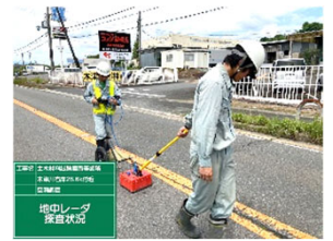
地中レーダ探査状況
