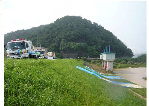
排水ポンプ車
