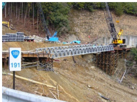
応急組立橋 (架設状況)
