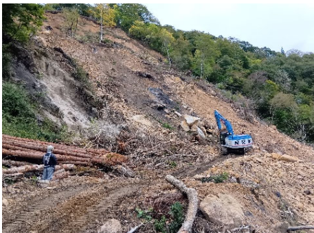
分解対応型バックホウ (無人化施工状況)
