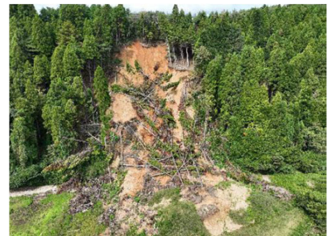
ドローン(UAV)による被災状況調査
