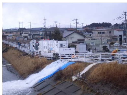
東日本大震災復旧支援(排水作業) (H23.3~H23.5)
