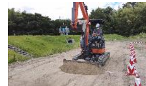
ICT施工比較 （2分39秒）
