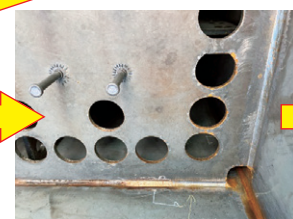
鋼製梁の孔開け状況(工場製作)
