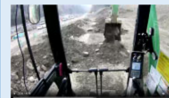
土砂移動作業の様子
