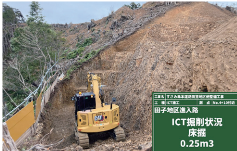
螺旋階段のような床掘形状
