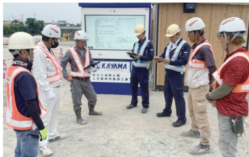
施工管理アプリを活用した朝礼
