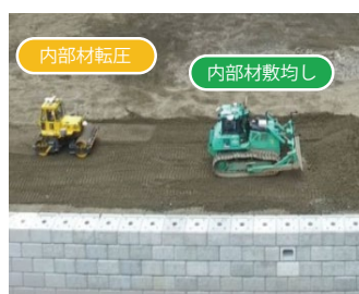
内部材の敷均し・転圧状況
