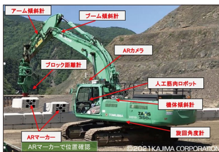
コンクリートブロック設置状況
