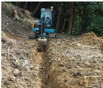
0.15m 3 級バックホウのICT建機化
