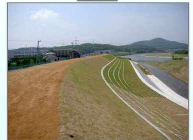
発注者：近畿地方整備局 姫路河川国道事務所 受注者：株式会社 田村組(兵庫県小野市)
