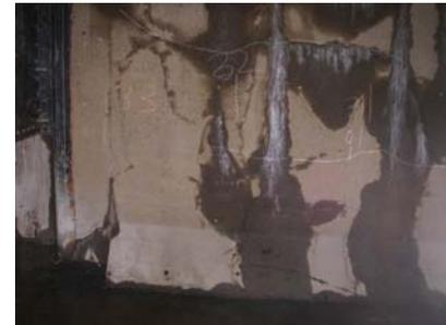
写真 1.4.3 ASRによるひび割れ
