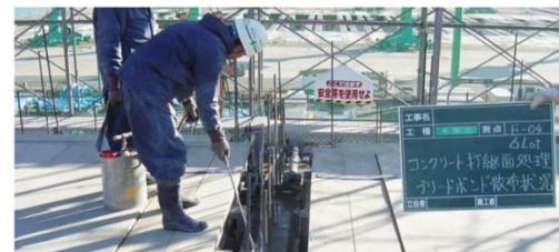
写真-2 施工状況(KT-110001-VE)
