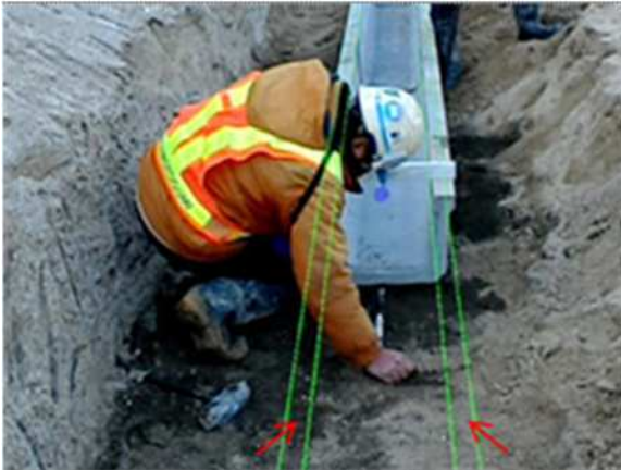
写真-3 ホロレンズを用いた MR 施工管理
