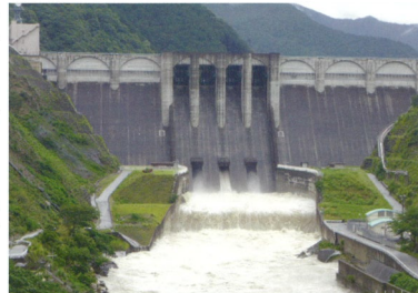
防災操作を実施する大滝ダム
