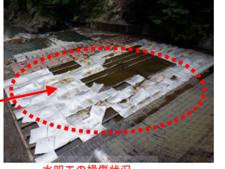
水叩工の損傷状況
