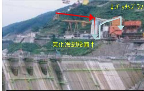
コンクリートの打設の際、一般的な練混ぜ水の冷却に加え気化冷却工法による細骨材冷却を併用しました。
