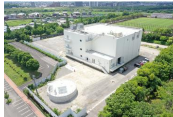
雨水ポンプ場
