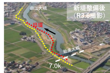
引堤(石川県梯川水系梯川)
