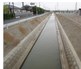
排水路の整備
