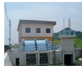
排水機場の整備
