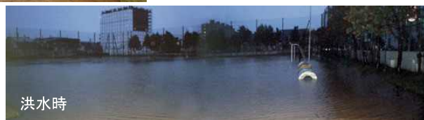
土手を整備し、貯留容量を確保
