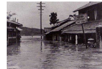
昭和28(1953)年台風13号による被害 伊賀市鍵屋の辻
