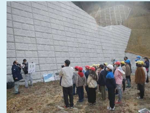
付近の砂防堰堤の見学 (向南谷砂防堰堤：R2年2月完成)
