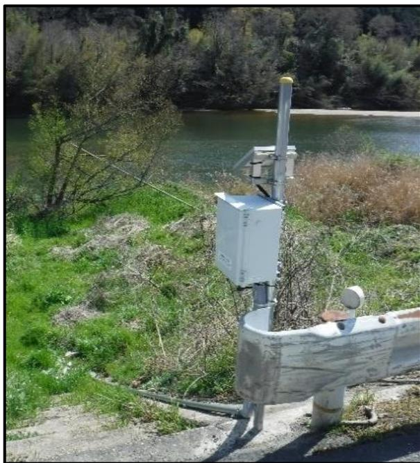
一定の水位を超過した時に観測モードを切り替え、10分以内毎に水位データを送信。水位データはクラウドで閲覧可能。
