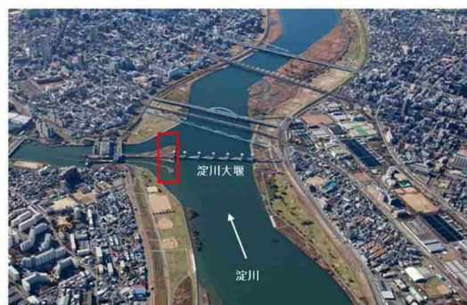
淀川大堰閘門設置位置 (平成26(2014)年11月)
