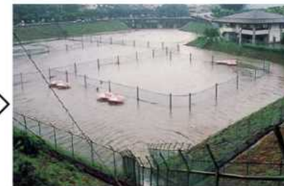
雨水貯留浸透施設の例(防災調整池)
