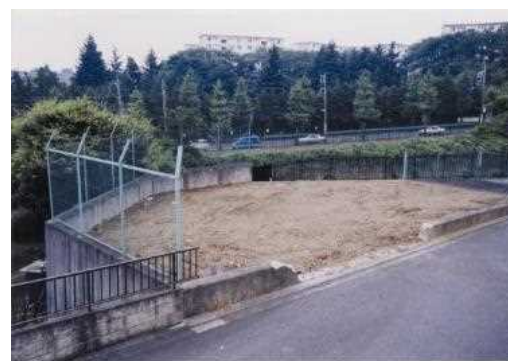
埋め立て後の状況
