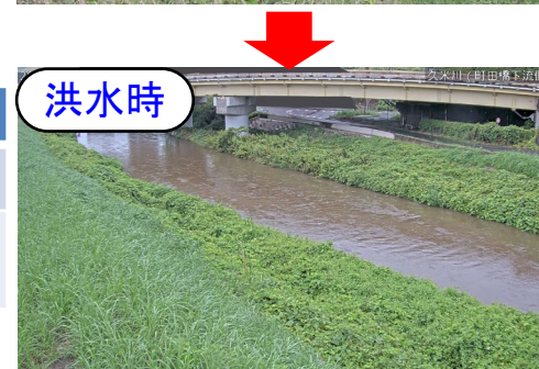
(写真:一級河川久米川)
