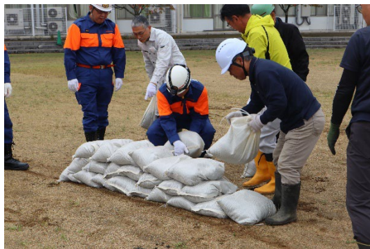
土のう作製、土のう積みの様子
