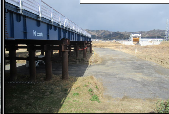
伊賀上野橋 仮橋上部工
