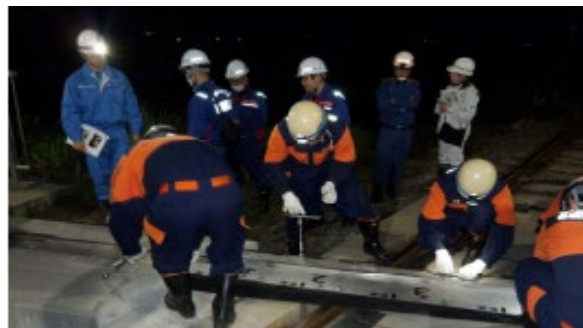
陸閘閉鎖(水密板の設置)
