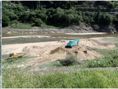
比奈知ダムでの堆積土砂除去工事の状況
