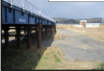
伊賀上野橋 仮橋上部工
