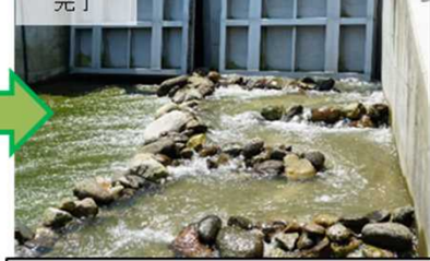
完了 流れを制限することで、水かさが増し、障害物をもうけて、休場をつくり遡上の手助けとなるポイントを設けた。
