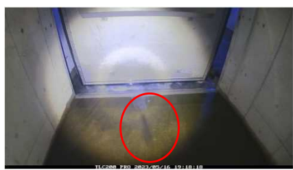
完了 段差が解消され、流速の遅いポイントを数カ所作ることで、休場をつくり遡上の手助けとなるポイントを設けた。
