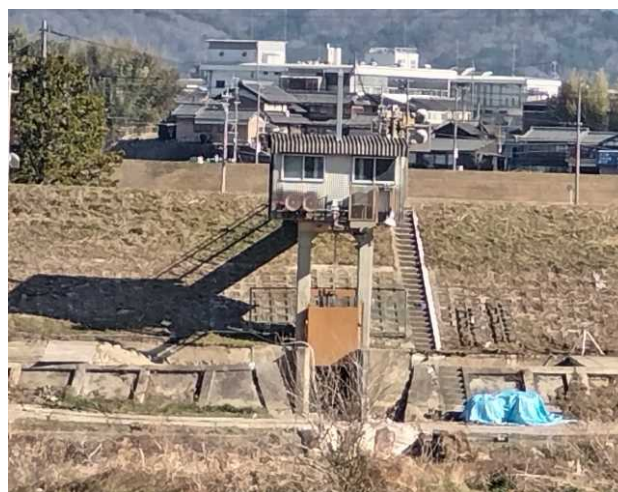
木津川 木興排水樋門(工事中)
