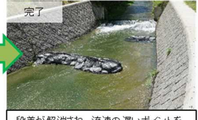
完了 段差が解消され、流速の遅いポイントを数カ所作ることで、休場をつくり遡上の手助けとなるポイントを設けた。
