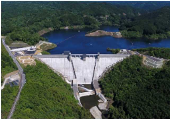
川上ダム全景写真
