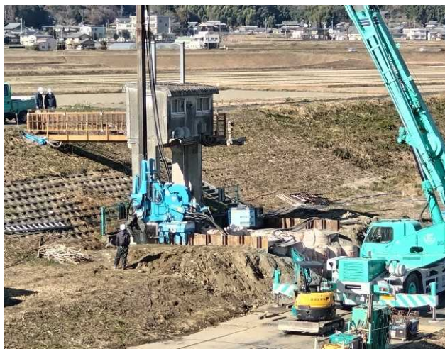
木津川 朝屋排水樋門(工事中)
