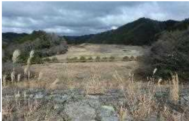
布目ダム堤体右岸脇ダムより望む
