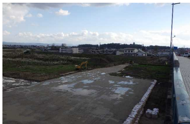
伊賀上野端:仮橋下部工
