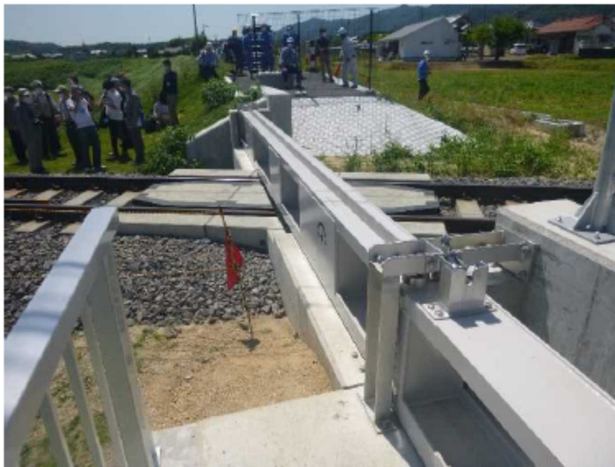
陸閘を閉鎖した状態(写真はR4年実施)
