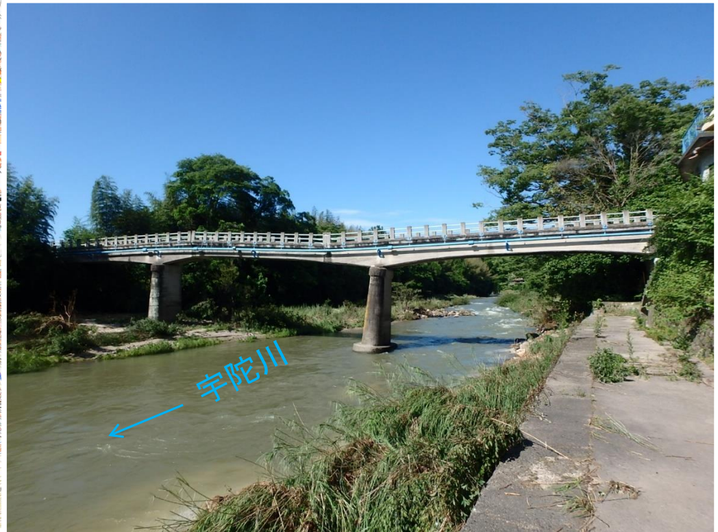
△坂之下橋の状況(R5.6)
