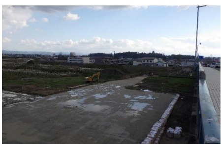
伊賀上野端:仮橋下部工
