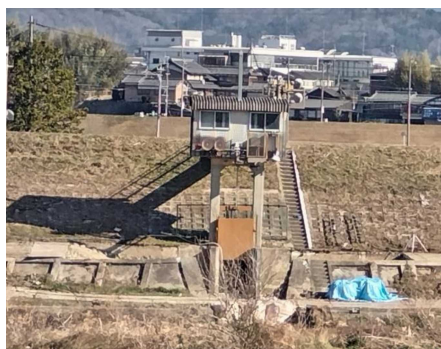
木津川 木興排水樋門(工事中)
