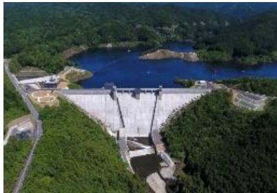
川上ダム全景写真
