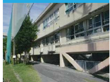
ピロティによる高床化
