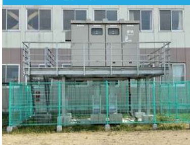
受変電設備のかさ上げ
