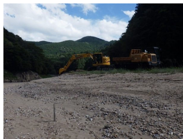
室生ダム副ダム堆積土砂除去工事の状況
