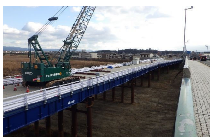
伊賀上野端：仮橋上部工
