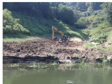
高山ダム堆砂除去工事の状況
