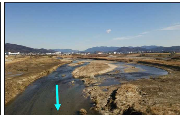
河道掘削後状況(近景)
