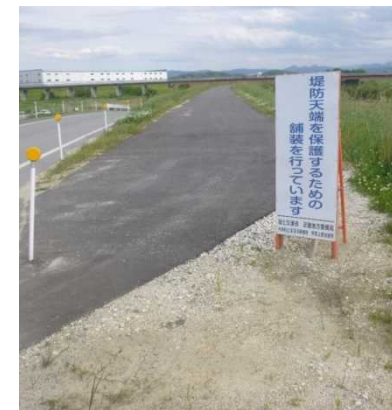
H28年度施工 木津川右岸
