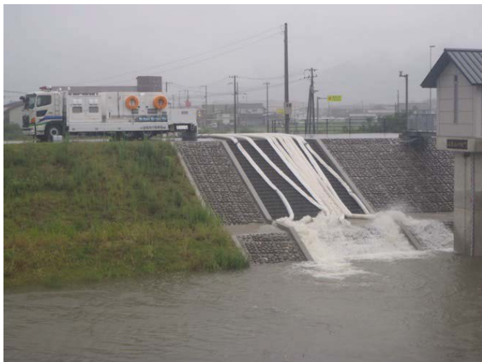
排水ポンプ車による内水排除状況
