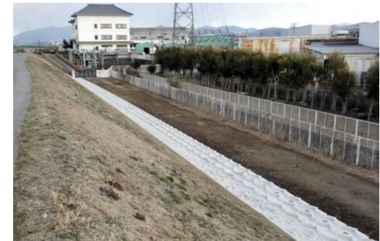
H29年度施工 服部川左岸
