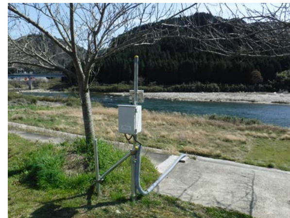
木津川43.4k右岸 (南山城村北大河原地先)
