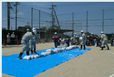
積み土のう設置
