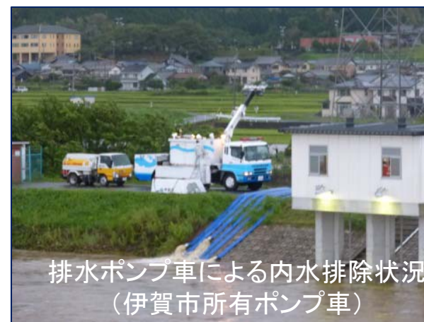
排水ポンプ車による内水排除状況
