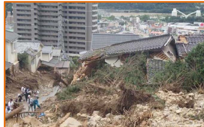
H26. 8月広島での土砂災害被害状況
