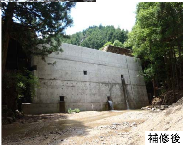
老朽化した砂防堰堤の補修対策（御杖村）
