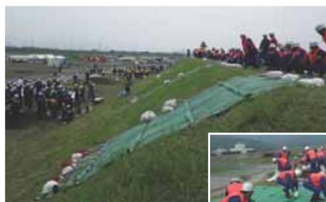
シート張り工
