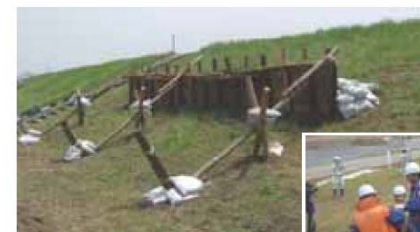
杭打ち積土のう工
