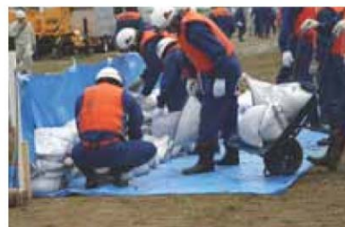
改良積土のう工
