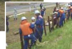
杭打ち積土のう工
