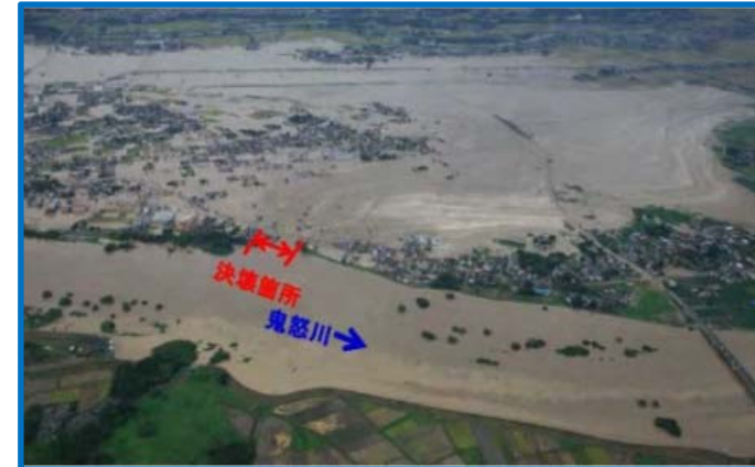
H27. 9月鬼怒川の氾濫浸水被害状況
