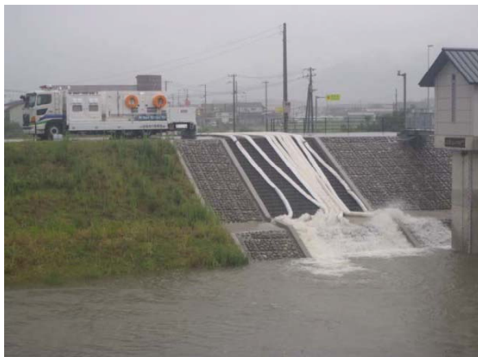
排水ポンプ車による内水排除状況
