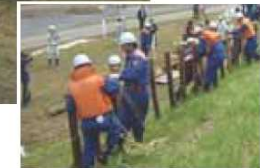
杭打ち積土のう工
