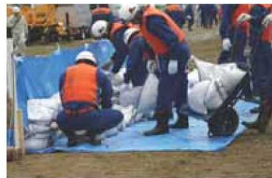
改良積土のう工
