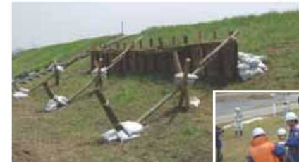
杭打ち積土のう工
