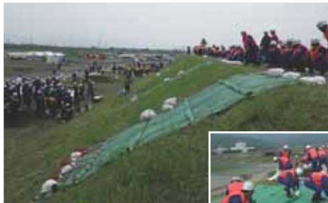
シート張り工
