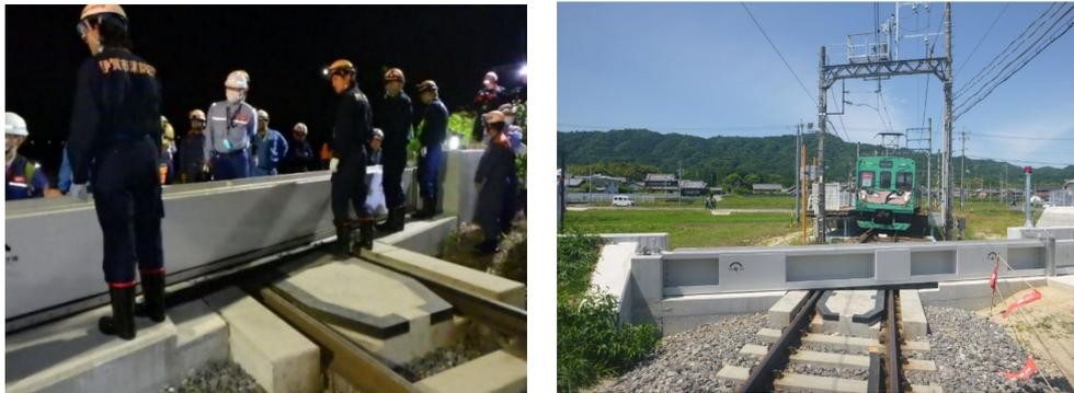
図 6.5.1 伊賀線第1陸閘の合同操作訓練（左）及び陸閘閉鎖時イメージ（右）
