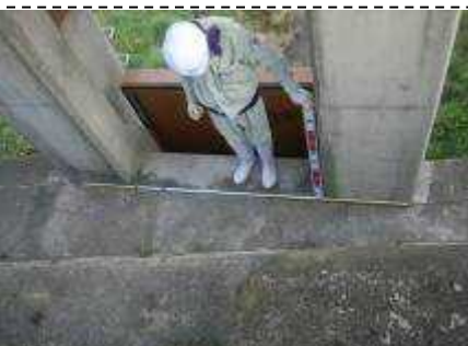
排水樋門点検状況
