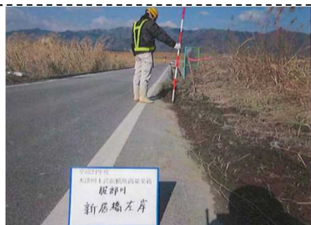
測量実施状況(護岸被災状況測量)
