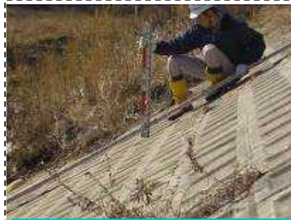
点検実施状況(護岸張ブロック部)
