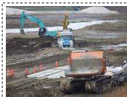
維持掘削実施状況
