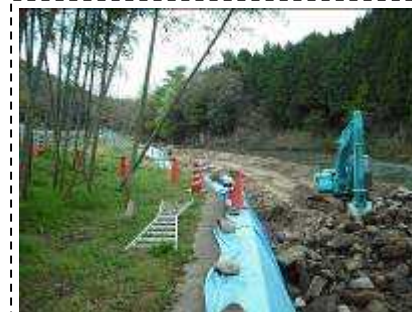
堤防、護岸補修状況
