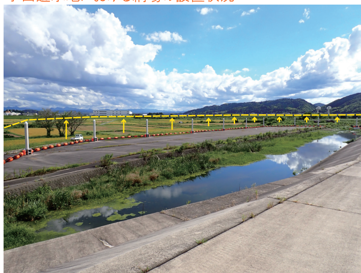
洪水が流入すると浮力でフロートが上昇し、網が張ります。
