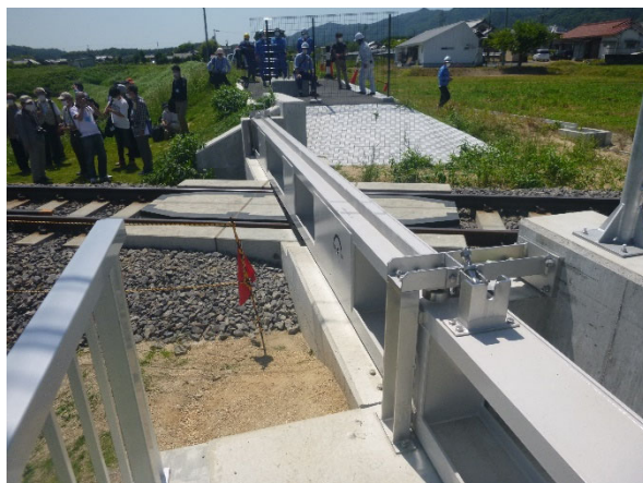
写真－1 陸閘を閉鎖した状態
