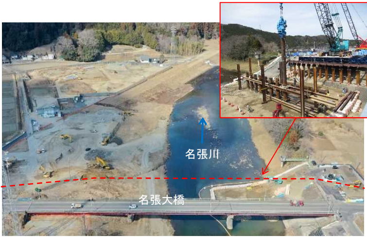
築堤工事、名張大橋迂回路設置工事
