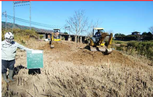
堆積土砂撤去
