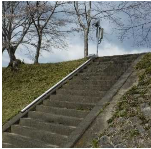
危機管理型水位計設置状況
