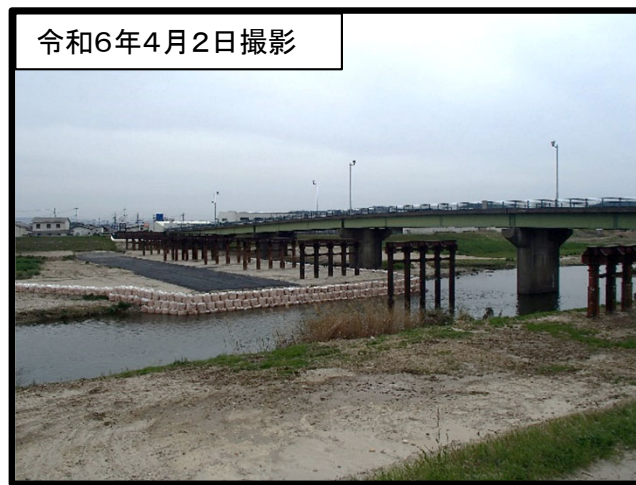
伊賀上野橋 仮橋下部工
