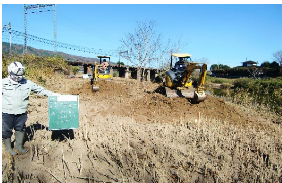
堆積土砂撤去
