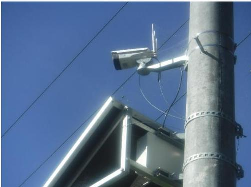
簡易型河川監視カメラ設置状況
