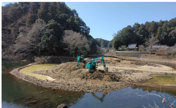
堆積土砂撤去
