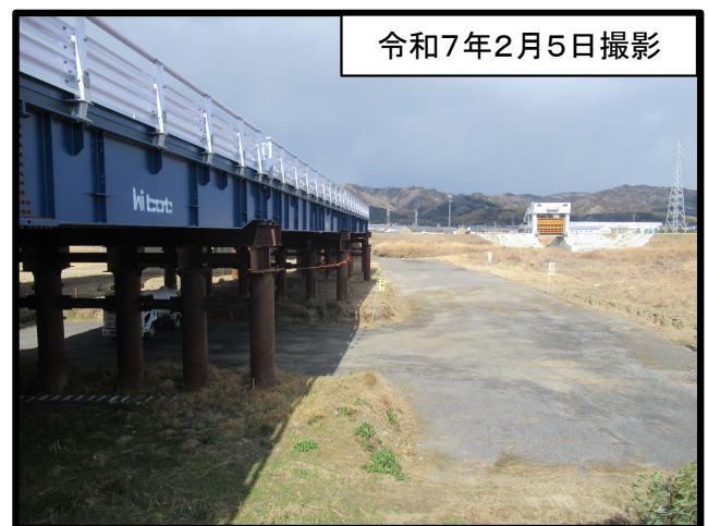
伊賀上野橋 仮橋上部工
