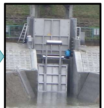
朝屋排水樋門 令和5年度改築
