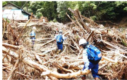
公共土木施設の被害状況の調査
