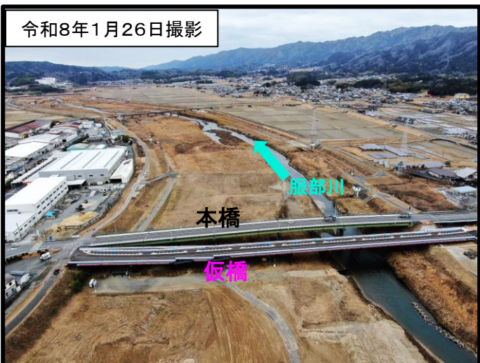
伊賀上野橋 仮橋施工状況
