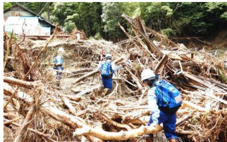
公共土木施設の被害状況の調査
