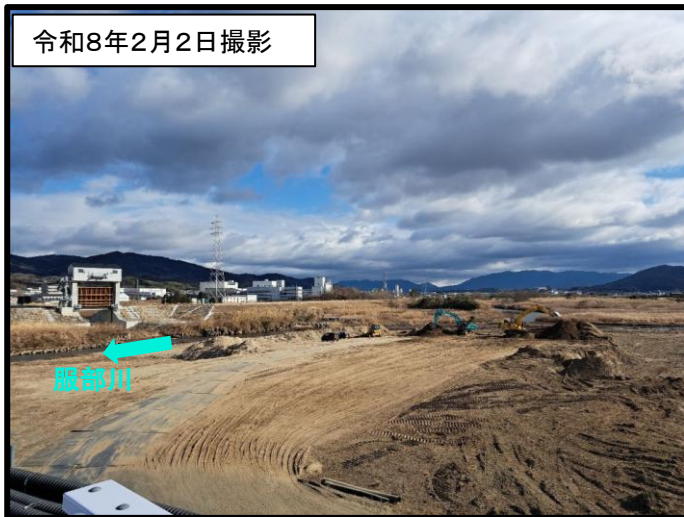
河道掘削施工状況
