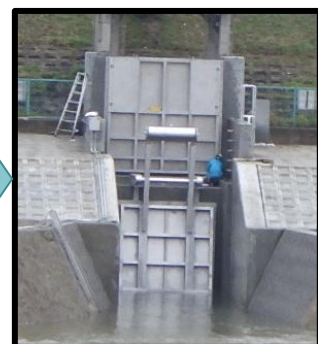
朝屋排水樋門 令和5年度改築
