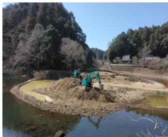
堆積土砂撤去
