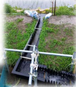
田んぼ入口に設置されている魚道の一部
