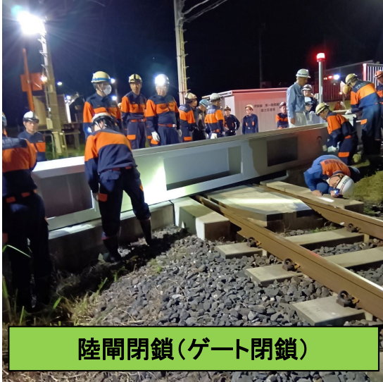
陸閘閉鎖(水密板の設置)
