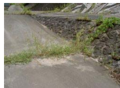
土砂の撤去により、雑草が少量生育 除草の効果あり
