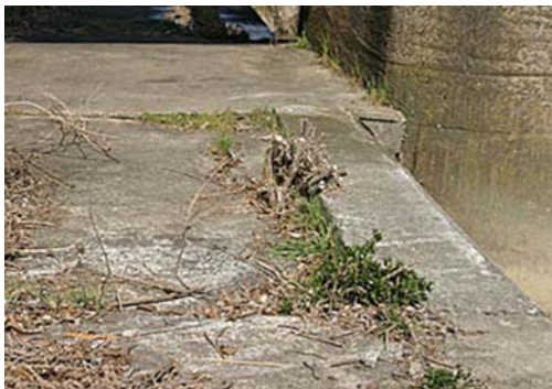
土砂堆積状況(作業中に確認)
