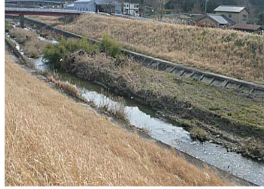
土砂堆積状況(作業中に確認)
