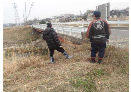
堤防点検のようす
